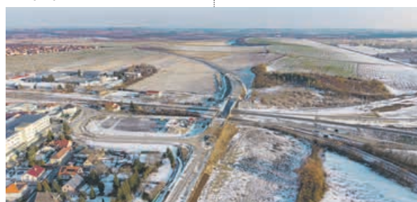
Stavba obchvatu Čelákovic z ptáčích perspektivy.
