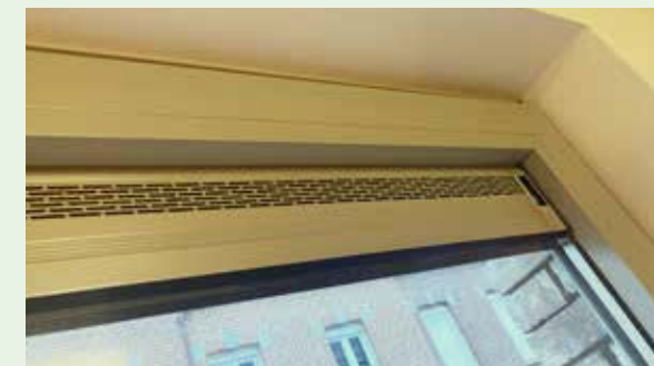
/ Voorbeeld van een manueel regelbare toevoeropening
