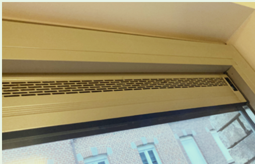
/ Voorbeeld van een manueel regelbare toevoeropening
