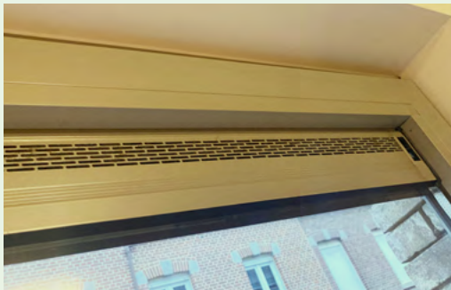
/ Voorbeeld van een manueel regelbare toevoeropening
