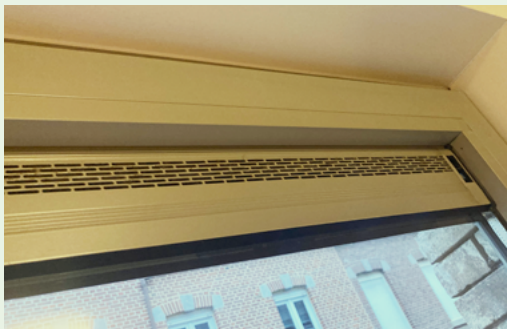
/ Voorbeeld van een manueel regelbare toevoeropening
