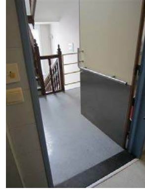
Hoge bescherming van het deurblad in inox. St. Lodewijk vzw, © Enter vzw
