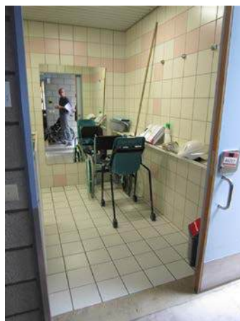
Schuifdeur naar een doucheruimte, met goede handgreep en vrij/bezet aanduiding.
