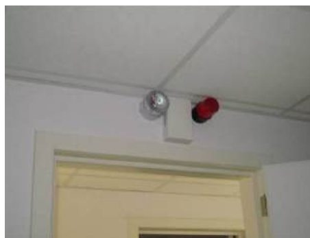
Een lichtflits die auditieve geluiden omzet in een visueel signaal (bel, een alarm, een telefoonoproep ...) KiDs vzw, ©Enter vzw
