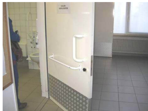
Deur met horizontale beugel en verticale handgreep. Dominiek Savio Instituut, © Enter vzw
