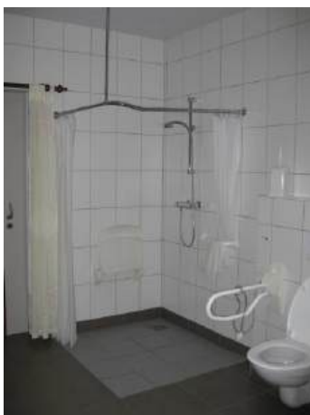
Drempelloze douchehoek met opklapbare douchezit. Stijn vzw, © Enter vzw
