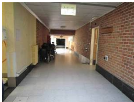
Verhoogde plint aan de muren. Hoeken met hoekprofielen in kunststof.
