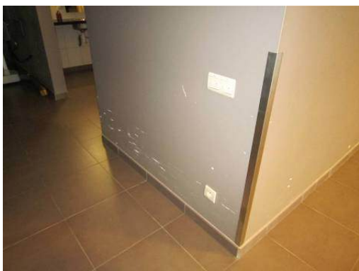
Beschadiging aan hoeken. Stijn vzw, © Enter vzw
