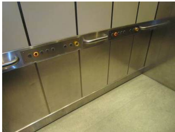
Horizontaal bedieningspaneel en handgrepen in de lift.
