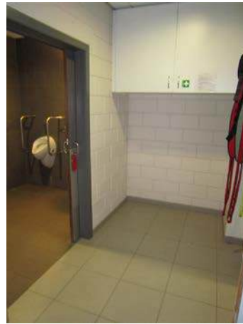
Tussensas tussen 2 ruimten doet dienst als extra transferruimte: hier blijft de rolstoel staan als er een verrijdbare tillift gebruikt wordt. Mané vzw, © Enter vzw
