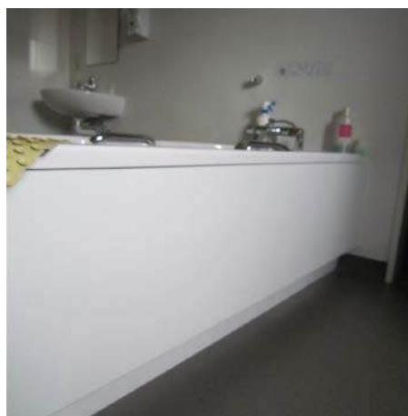
Vrijstaand bad op normale hoogte, met ingewerkte handgrepen en onderstaanbaar uitgevoerd. Zorgcentrum Maria - Ter - Engelen vzw, © Enter vzw
