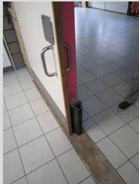
Beschadiging van een raamkader - Beperkte voeg in vloerbetegeling – Overgang verschillende vloerafwerking.
