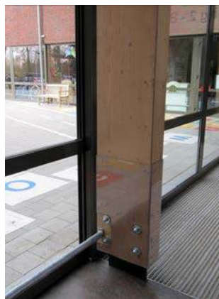
Plexi plaat en stalen stang ter bescherming van kolommen en glazen wanden.
