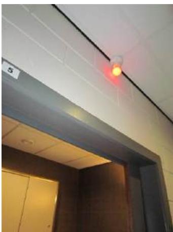
Verkliklamp wanneer het toilet in gebruik is, gekoppeld aan het licht in de toiletruimte. Mané vzw, © Enter vzw
