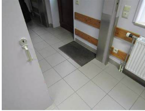
Bescherming van de deurstijlen in inox. Stijn vzw, © Enter vzw
