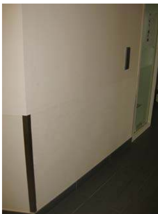
Bescherming van de hoeken d.m.v. inox hoekprofiel en van de wanden d.m.v. cementering en een afwerking met tusk (wandafwerking op basis van geslepen glasdeeltjes).
