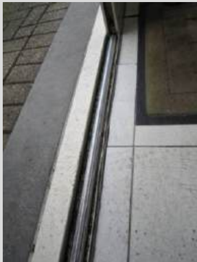
Beschadiging van een raamkader - Beperkte voeg in vloerbetegeling – Overgang verschillende vloerafwerking.
