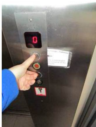
Toegang tot de lift is beveiligd doordat je twee knoppen tegelijk moet indrukken.
