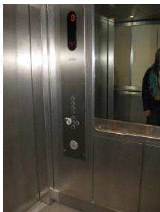
Verticaal bedieningspaneel op goede gebruikshoogte, maar een beperkte afstand tot de hoek.
