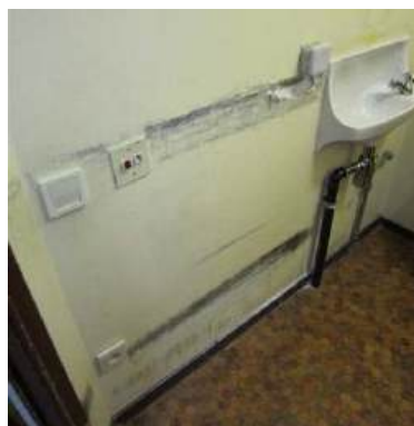
Wandbeschadiging door voetsteunen en joystick van de rolstoel. Eigen thuis vzw, © Enter vzw
