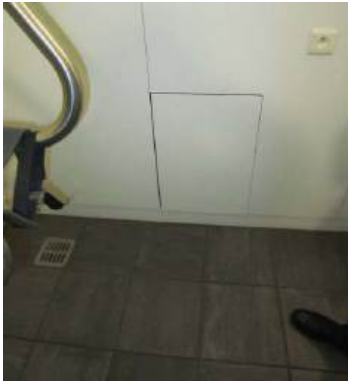
Voetbel, geplaatst ter hoogte van het toilet: Het vlak in de muur kan aangereken worden met de voetsteunen van de rolstoel. Achter de plaat zit een tuimelschakelaar verwerkt. Eigen Thuis vzw, © Enter vzw
