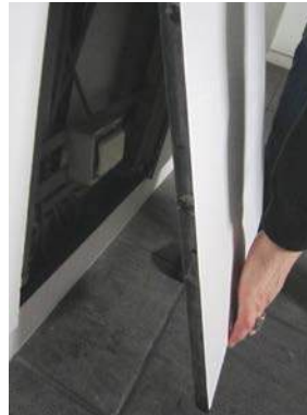
Voetbel, geplaatst ter hoogte van het toilet: Het vlak in de muur kan aangereken worden met de voetsteunen van de rolstoel. Achter de plaat zit een tuimelschakelaar verwerkt. Eigen Thuis vzw, © Enter vzw
