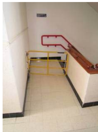
Trapbeveiliging voor rolstoelgebruikers. De leuning loopt 40 cm door voorbij de trede en is afgerond van vorm. St. Lodewijk vzw, © Enter vzw
