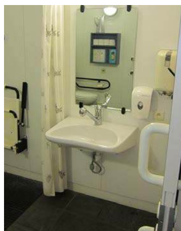
Wastafel met kraan met hogere uitloop (en met sproeikop) in een badkamer. Eigen Thuis vzw, © Enter vzw
