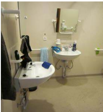
Wastafel gemonteerd op een in hoogte verstelbaar systeem en uitgevoerd met een flexibele afvoer. Revalidatiecentrum UZ Gent, © Enter vzw
