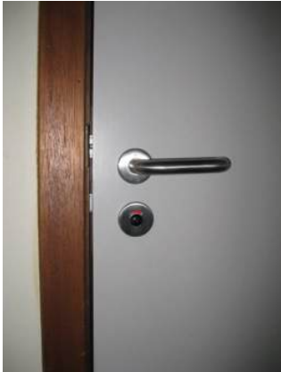
Goed omgrijpbare L-vormige deurkruk.
