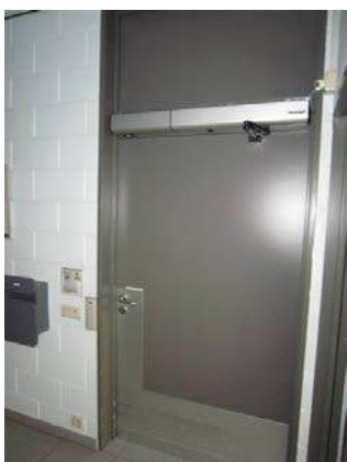
Inkomdeur met automatische deuropener bediend d.m.v. elleboogschakelaar. Mané vzw, © Enter vzw
