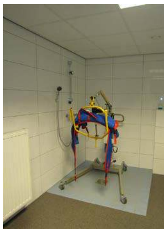
Vlakke douche met verrijdbare tillift. Naast de doucheglijstang is een extra douchekophouder op bereikbare hoogte voor zorgverleners.
