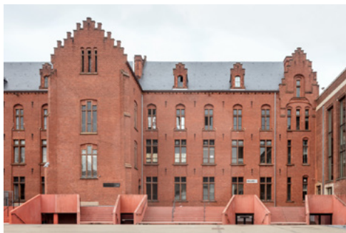
Tijdens de renovatie van het Virga Jesse College werden twee nieuwe volumes toegevoegd: een inkom en een nieuwe sokkel dat halfondergronds een nieuwe sanitaire blok en een polyvalente ruimte huisvest. ©Stijn Bollaert
