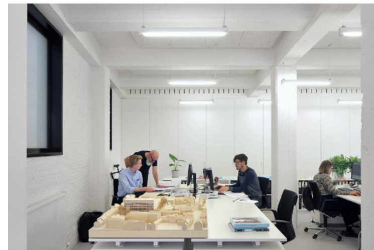
In het kantoorgebouw van META werden de bakstenen muren niet bepleisterd en werd er geen verlaagd plafond voorzien © Filip Dujardin
