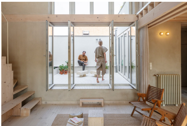
Bij de optopping van de KAPER-woning werd maar een beperkt aantal materialen gebruikt. Hout komt bijvoorbeeld terug als structureel materiaal, maar ook als materialisatie van de trap en van het meubilair. © Tim Van de Velde
