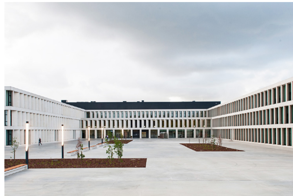
Het ziekenhuis AZ Groeninge werd ontworpen om opgebouwd te worden in verschillende fases. Demonteerbare gevelelementen maken deze uitbreidingen mogelijk. Ook werden er demonteerbare dakelementen voorzien om grote installaties te vervangen in de toekomst of om grote toestellen binnen te brengen. ©Kris Van de Vijver
