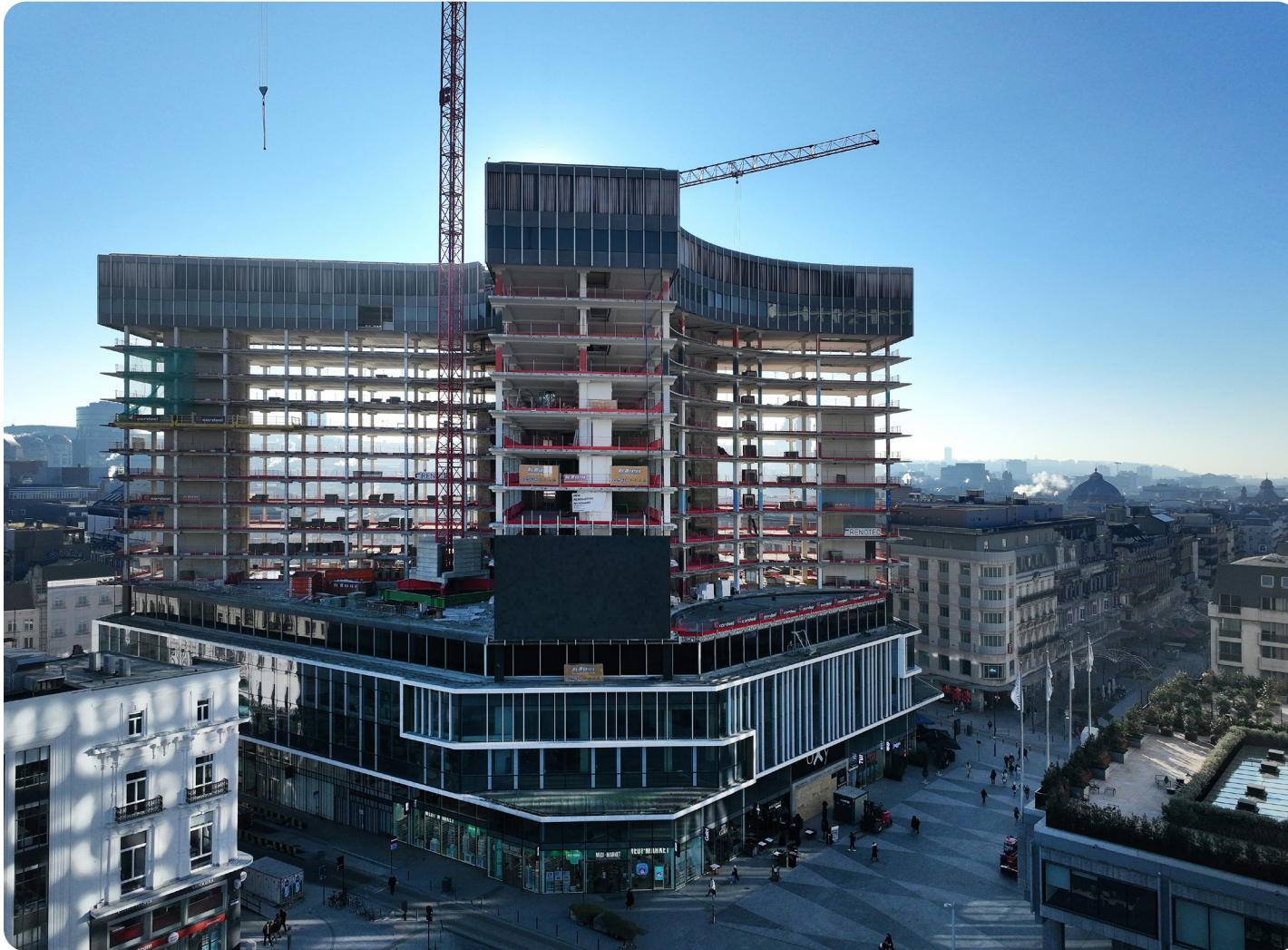
OXY Brussel, skelet van het gebouw. © Brison Photographie
