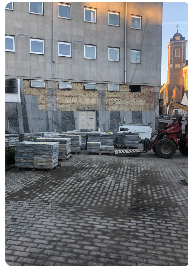
Ontmantelen van natuurstenen buitenafwerking. © Stad Mechelen
