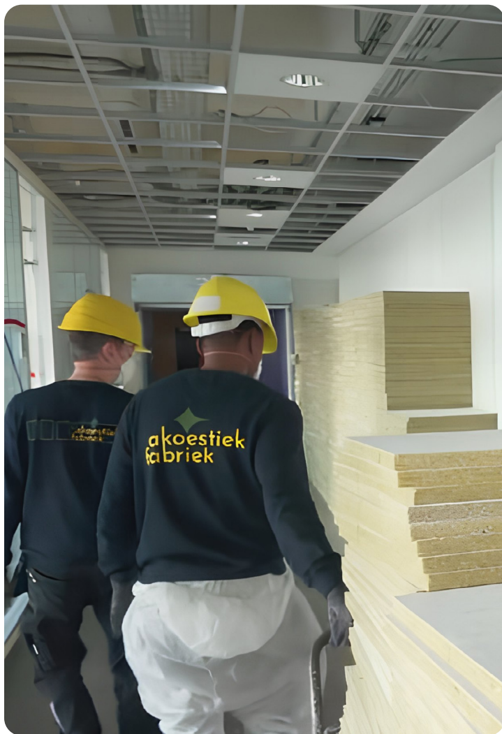
Het ontmantelen en afnemen van de plafondpanelen uit Gebouw 32 gebeurde door Akoestiekfabriek. © Content Company
