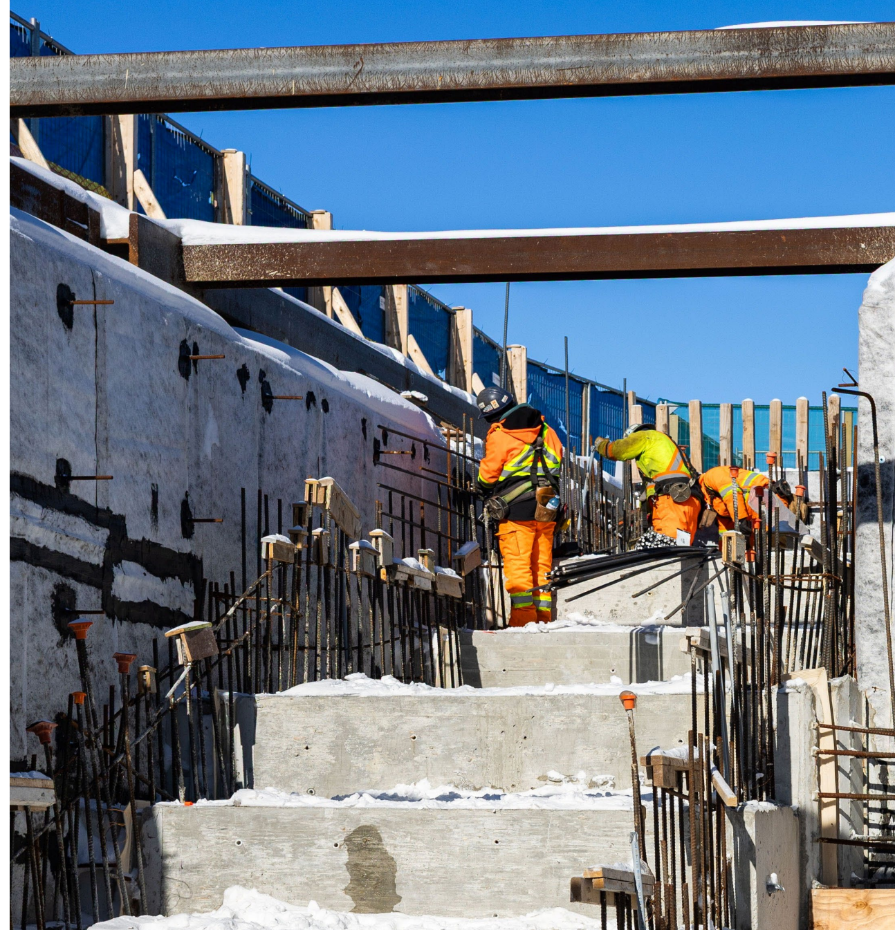
Travailleurs du chantier attachant des barres d'armature sur les murs de l'escalier nord du tunnel est. Image de Metrolinx.
