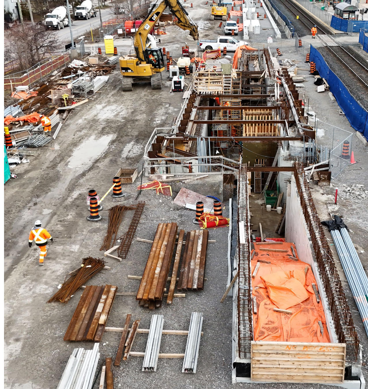
Travaux de coffrage et de décoffrage dans le cadre de la construction du tunnel ouest. Image de Metrolinx
