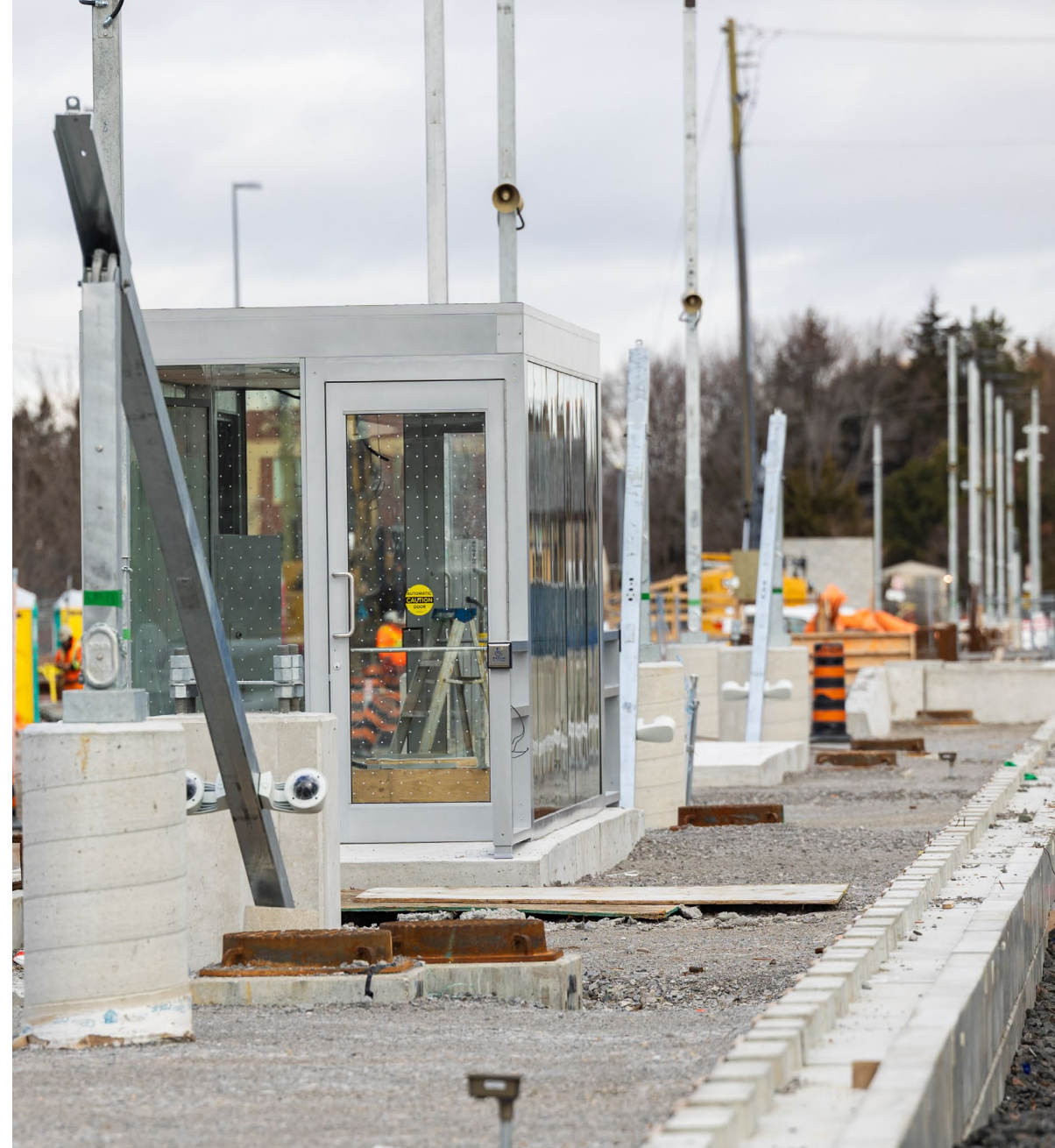
Travaux dans l'aire du quai ouest, y compris la structure de l'abri, les poteaux de services publics et d'éclairage, ainsi que les manivelles électriques pour les conduits d'alimentation et de communication. Image de Metrolinx
