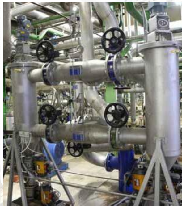
2 pk. Auto-line® XXL-R-E for filtrering av sirup fra sukkerroer
