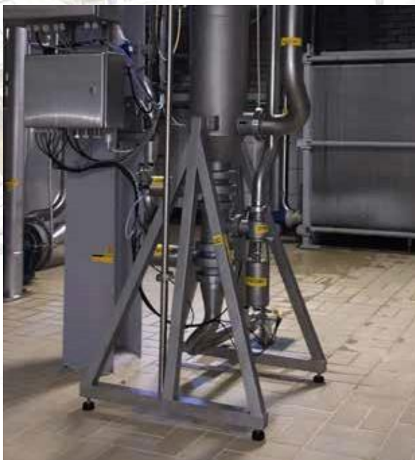
Auto-line® LE for filtrering av myse i en ostefabrikk
