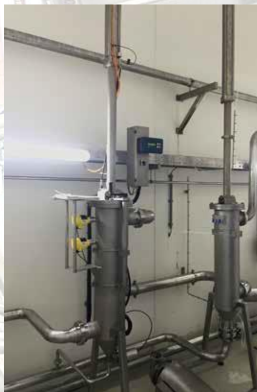
2 pk. Auto-line® XLE for filtrering av lake fra saltlakebad i en produksjonsfasilitet for hard-ost
