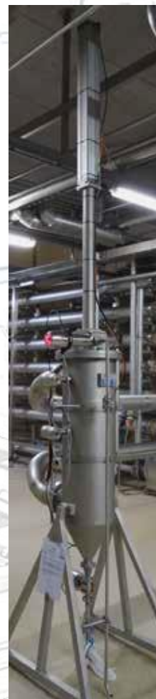
Auto-line XXLE sikkerhetsfilter for kondensatfiltrering før UF/RO-installasjon
