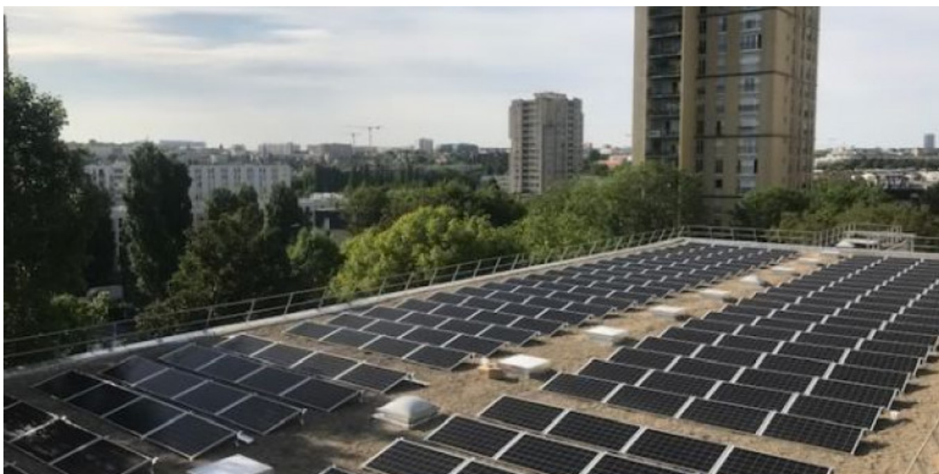
Panneaux sur le toit de l'école La plaine - Crédit : Sud Paris Soleil
