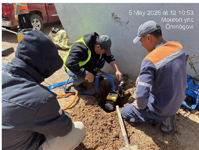
Зураг 11. Хүчин чадал сайтай насос болон генератор залгаснаар ус нөөцлөх савнаас ус авах хурд сайжрав. Мөн сумаас усны сав бүхий ачааны портер машин түрээслэснээр шланг хүрэхгүй талбайг услах ажил илт сайжирсан. 2026.05.05
