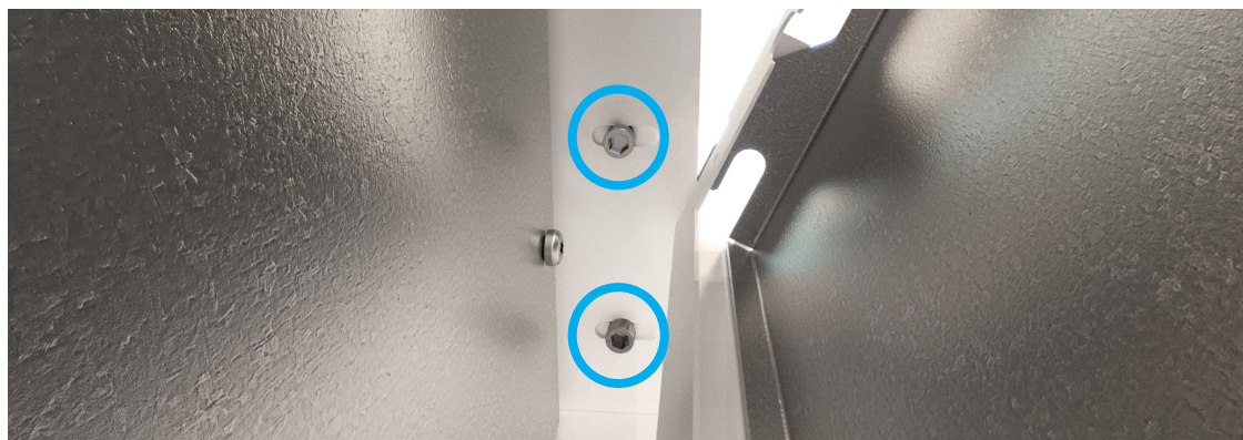
Montering av den kaklingsbara ramen.
