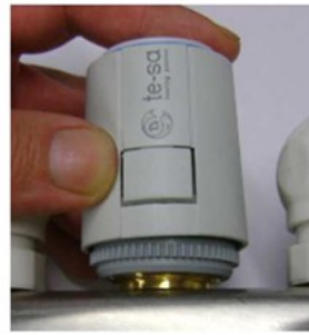
3. Fest aktuatoren på returventilen
