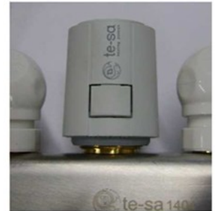
4. Ferdig på satt aktuator på returventil
