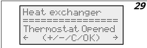
Fig. 29 Varmtvannsbereider med termostat
