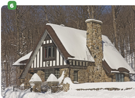
▲ NOS LUGARES MUITO FRIOS, AS MORADIAS COSTUMAM TER TELHADOS INCLINADOS PARA NÃO ACUMULAR NEVE. MORADIA NO CANADÁ, 2020.
