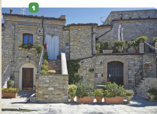
▲ ANTIGAMENTE, ERA MUITO COMUM O USO DE PEDRAS NA CONSTRUÇÃO DE CASAS. MORADIA NA ITÁLIA, 2020.
