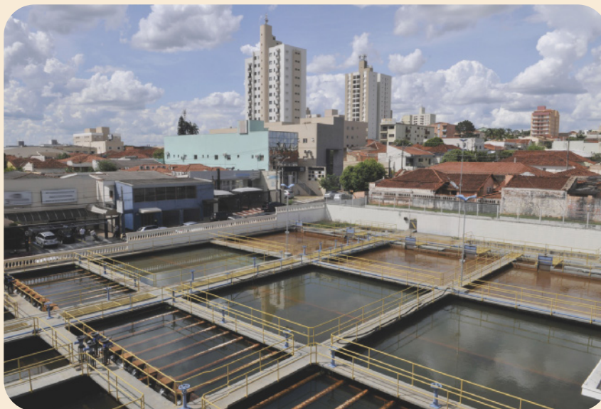
● Estação de tratamento de água em São José do Rio Preto, São Paulo, em 2018.
