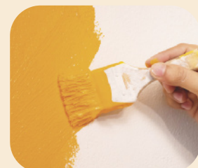
● PINTURA DE PAREDE COM GEOTINTA.
