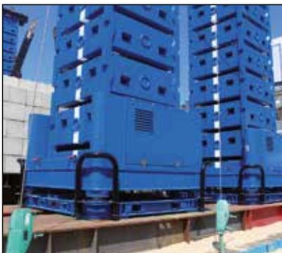
▼ Hubsystem von Enerpac hebt 1500 t schweren Brückenträger der Fore River Bridge an.
