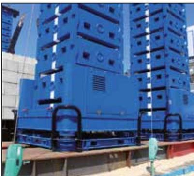
▼ Sistema Jack-Up de Enerpac levanta un tramo de 1500 toneladas para el puente del río Fore.
