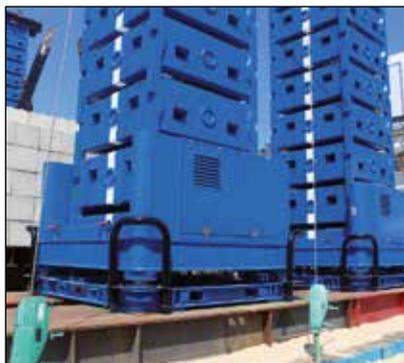
▼ Il sistema Enerpac in opera per il sollevamento di un tratto del ponte sul fiume Fore da 1500 tonnellate.
