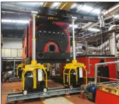
▼ Pórtico SBL1100 que descarga un generador grande para su instalación en una central eléctrica.
