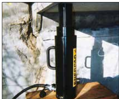
◀ Un cilindro in alluminio con ghiera di sicurezza RACL1506, sostiene il carico durante l'operazione di iniezione di resina epossidica per il rinforzo di un ponte.
