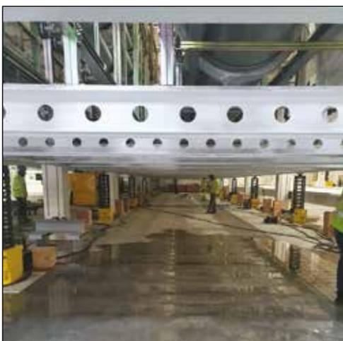
◀ *Completato in poco più di un'ora, il sistema di scaffalature in acciaio da 160 tonnellate 50 x 7 metri è stato sollevato in modo sincrono a un'altezza di 2,2 metri utilizzando 16 martinetti cubici Enerpac SCJ50 alimentati da una singola pompa a flusso diviso della serie SFP. Il sollevamento di grandi sistemi di scaffalature può essere pericoloso, complesso e difficile, coinvolgendo carrelli elevatori e paranchi a catena. Foto per gentile concessione di PHL Hydraulics Ireland Ltd.*
