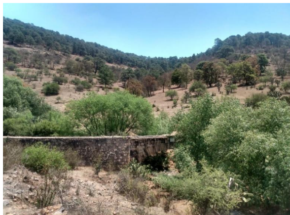
Figura 1. Fragmento del acueducto dentro de la ZRPA.
