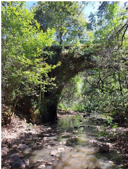
Figura 3. Arco de una parte del acueducto histórico dentro de la ZRPA.
