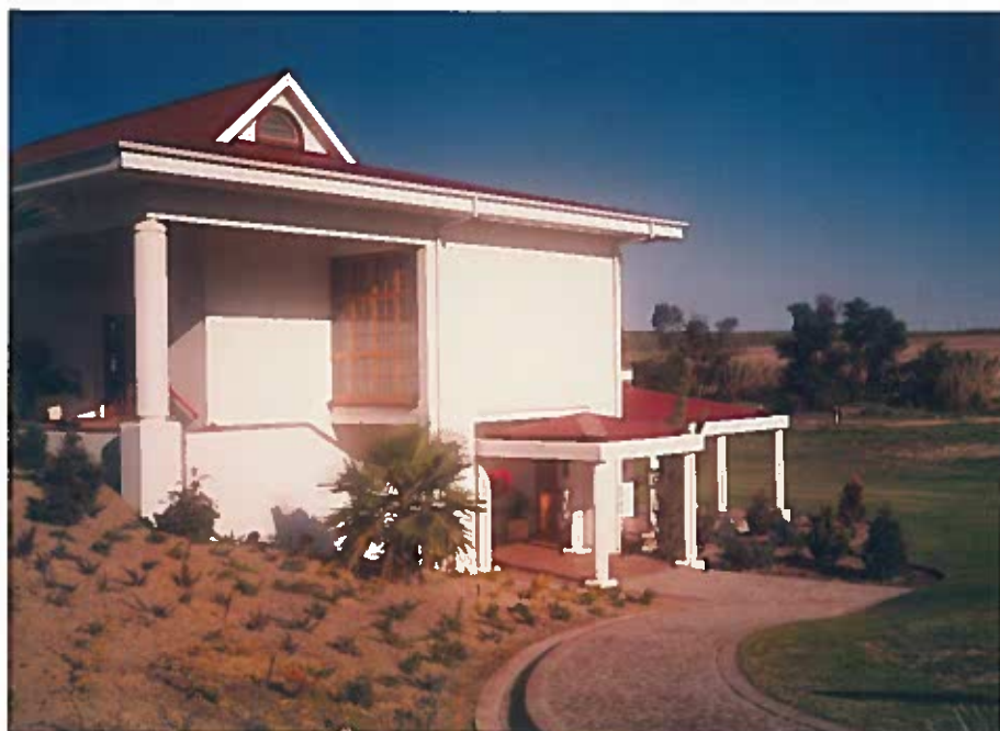
EETSAAL VANAF WESTEKANT
