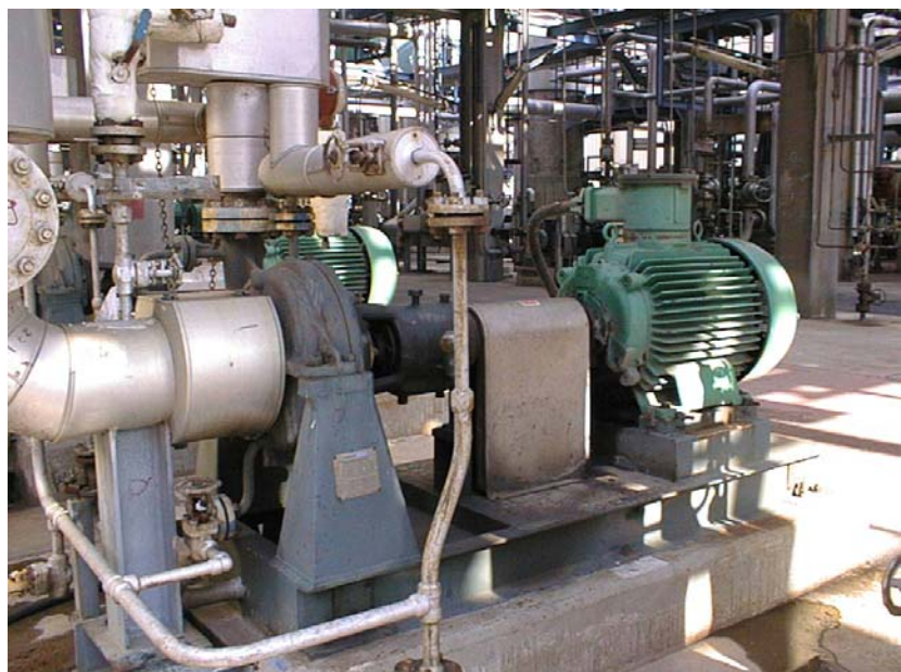
Figure 2: Exemple de pompe centrifuge de type Aspiration Axiale
