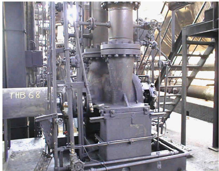
Figure 67: Pompe procédé TT, roue double entre paliers
