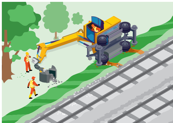
▲ Renversement d'une pelle rail-route.
