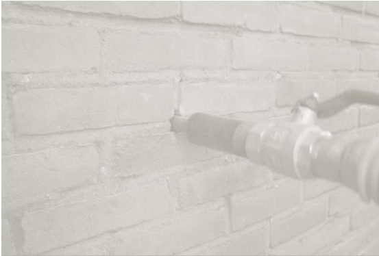
Spouwmuurisolatie
