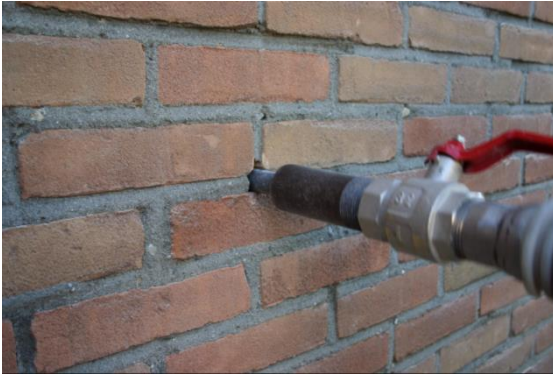
Spouwmuurisolatie
