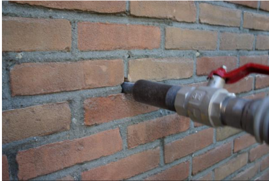
Spouwmuurisolatie
