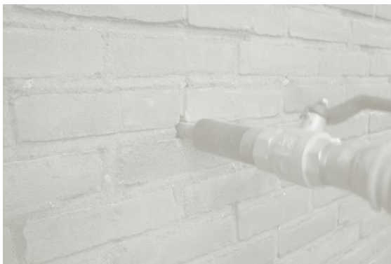
Spouwmuurisolatie
