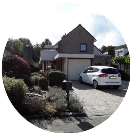
Vrijstaande woning Bouwjaar 1975
