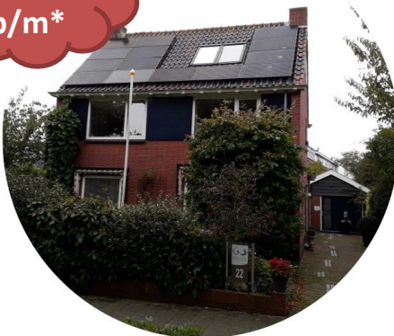
Vrijstaande woning Bouwjaar 1962
