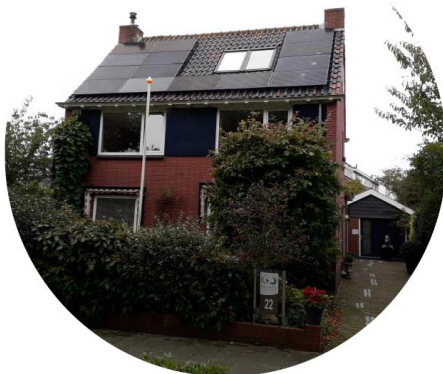
Vrijstaande woning Bouwjaar 1962
