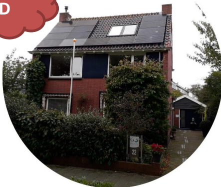
Vrijstaande woning Bouwjaar 1962
