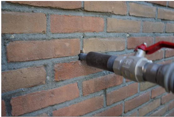
Spouwmuurisolatie
