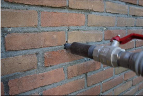
Spouwmuurisolatie
