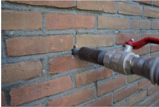
Spouwmuurisolatie
