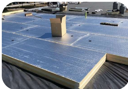
Plat dakisolatie buitenzijde
