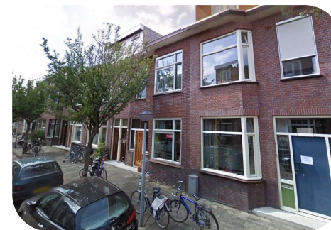
Geïsoleerd plat dak buitenzijde 8 – 10 centimeter
