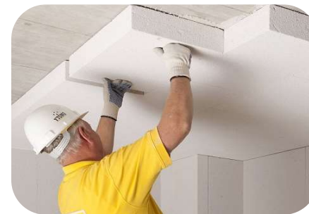
Plat dakisolatie binnenzijde
