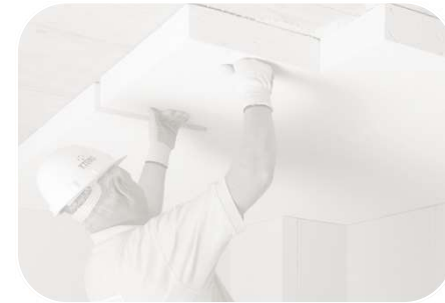
Plat dakisolatie binnenzijde
