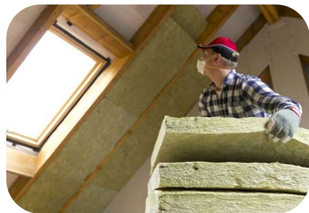
Schuin dakisolatie binnenzijde
