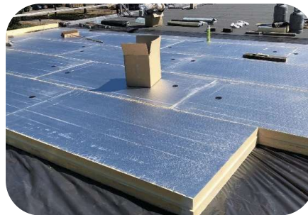
Plat dakisolatie buitenzijde
