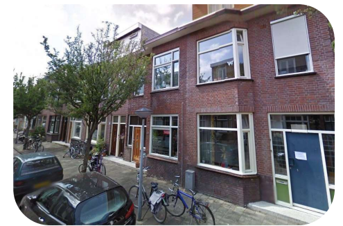
Ongeïsoleerde betonnen vloer
