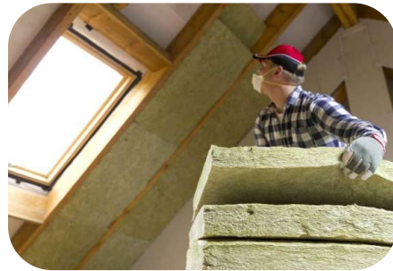
Schuin dakisolatie binnenzijde
