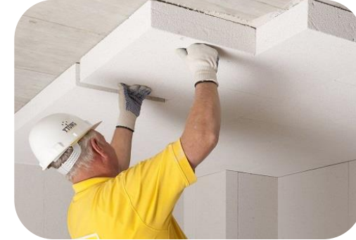
Plat dakisolatie binnenzijde
