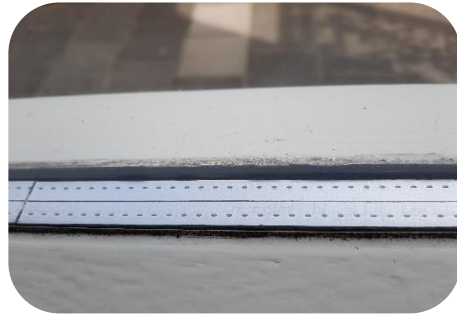
42 m 2 beglazing (geheel) Gehele woning HR++ beglazing Houten kozijnen
