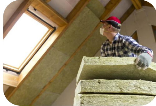
Schuin dakisolatie binnenzijde
