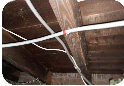
Houten constructievloer Kruipruimte niet toegankelijk 90 cm hoog 90 cm bodemisolatie chips
