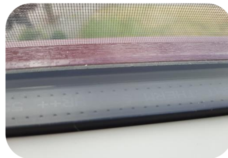
20 m 2 beglazing (11 m 2 verdieping) Bijna overal HR++ beglazing Zowel houten als kunststof kozijnen
