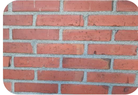
Spouwmuur, 5 cm EPS parels
