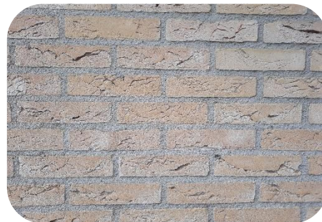
Spouwmuur, 7 cm min wol, 5 cm over
