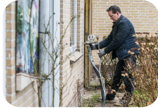
Spouwmuurisolatie
