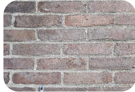
Enkelsteens muur, voorzetwand 4 cm PIR
