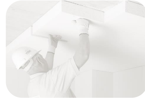
Plat dakisolatie binnenzijde
