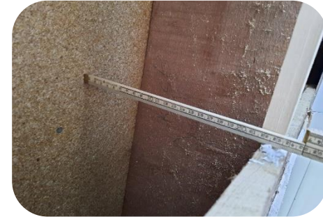
Geïsoleerd vanuit bouw 4 cm PUR Niet aanvullend geïsoleerd
