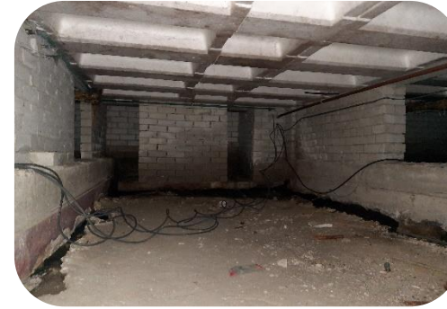
Betonnen constructievloer EPS vanuit bouw 130 cm hoog Niet aanvullend geïsoleerd
