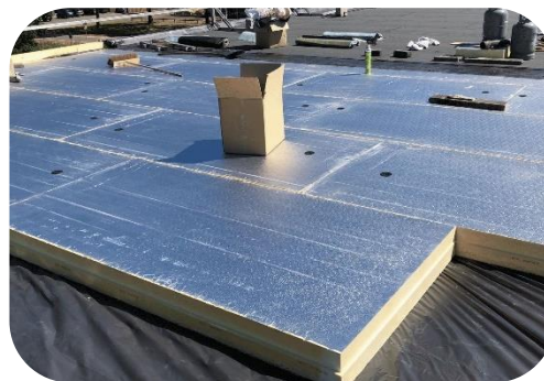
Plat dakisolatie buitenzijde
