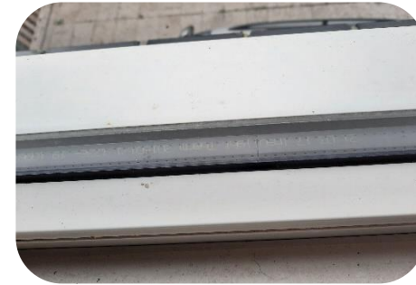
26 m 2 beglazing (10 m 2 verdieping) Gehele woning HR++ beglazing Kunststof kozijnen
