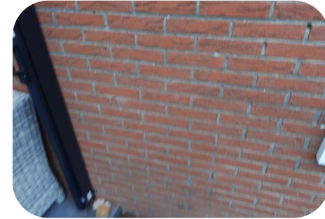
Spouwmuur, 3 cm min wol, 5 cm over
