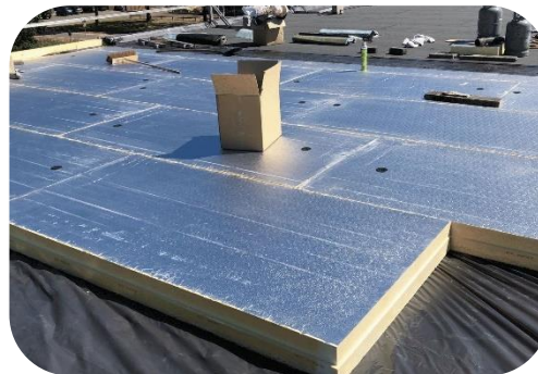
Plat dakisolatie buitenzijde
