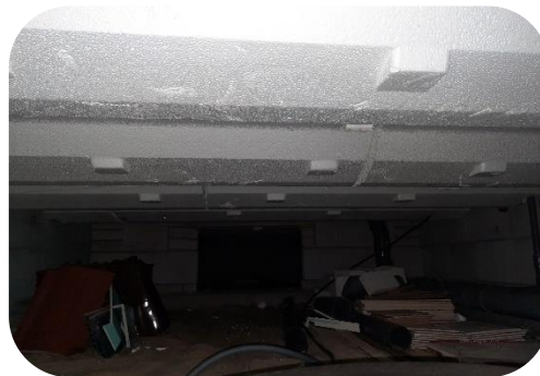
Betonnen constructievloer EPS vanuit bouw 60 cm hoog Niet aanvullend geïsoleerd
