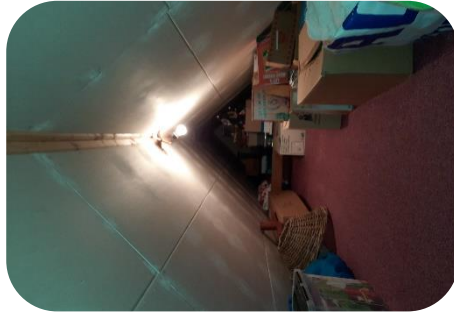
Ongeïsoleerd vanuit bouw Aanvullend geïsoleerd 7 cm PIR
