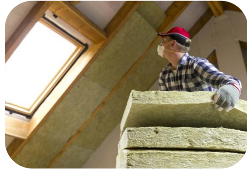
Schuin dakisolatie binnenzijde
