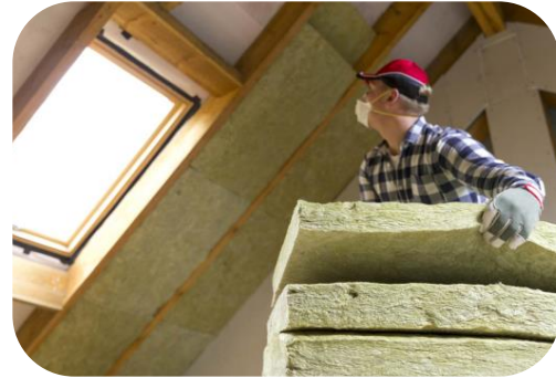
Schuin dakisolatie binnenzijde
