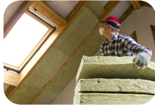
Schuin dakisolatie binnenzijde
