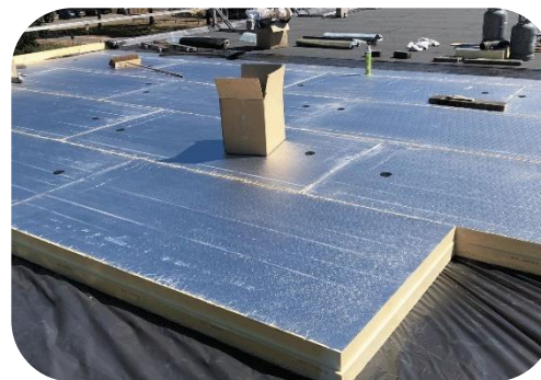
Plat dakisolatie buitenzijde
