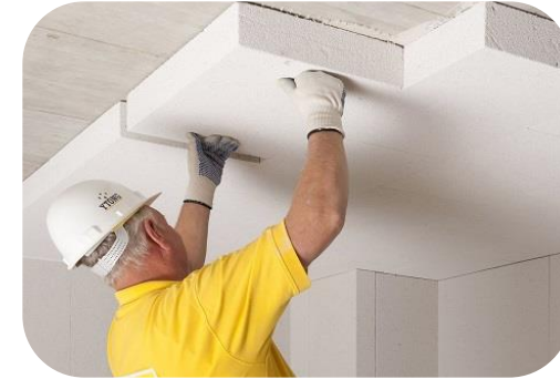
Plat dakisolatie binnenzijde
