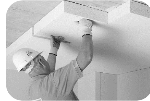
Plat dakisolatie binnenzijde
