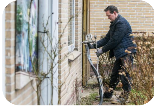
Spouwmuurisolatie
