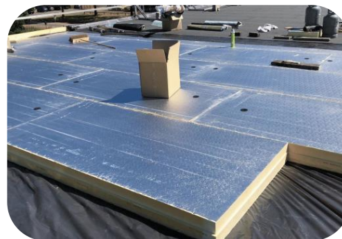
Plat dakisolatie buitenzijde
