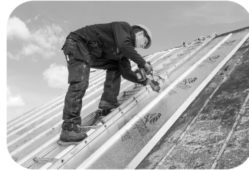
Schuin dakisolatie buitenzijde
