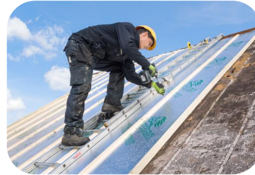
Schuin dakisolatie buitenzijde
