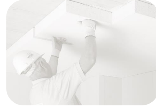
Plat dakisolatie binnenzijde
