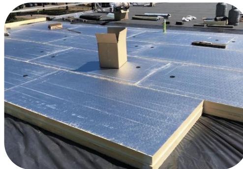
Plat dakisolatie buitenzijde
