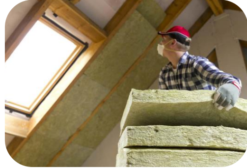
Schuin dakisolatie binnenzijde
