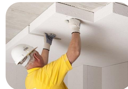
Plat dakisolatie binnenzijde
