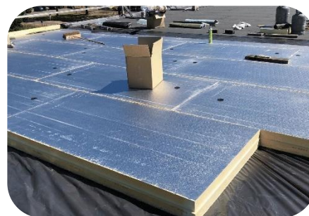
Plat dakisolatie buitenzijde
