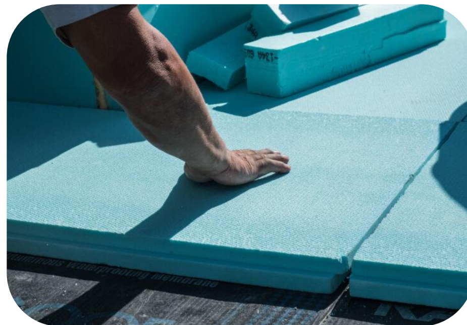
Bovenzijde vloer isoleren
