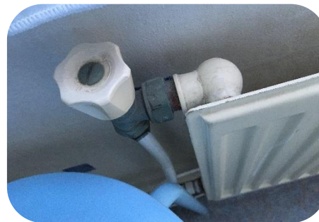
Conventionele Radiatoren, middelhogte temperatuur
