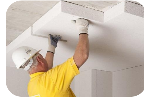
Plat dakisolatie binnenzijde
