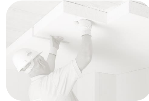
Plat dakisolatie binnenzijde
