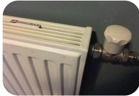
Conventionele Radiatoren, middelhogte temperatuur
