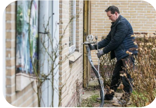
Spouwmuurisolatie
