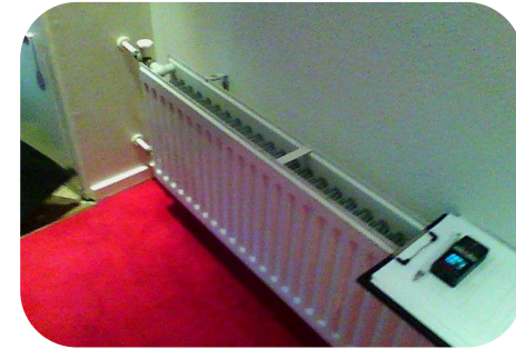
Conventionele radiatoren, middelhogte temperatuur
