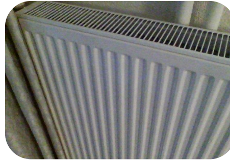
Conventionele Radiatoren, middelhogte temperatuur
