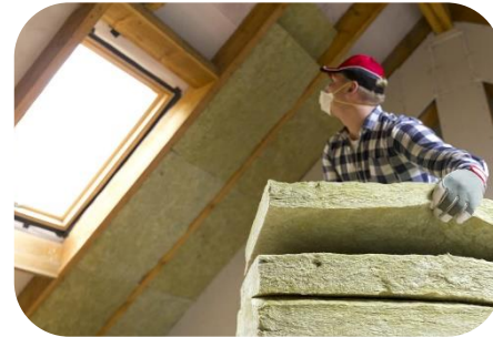
Schuin dakisolatie binnenzijde
