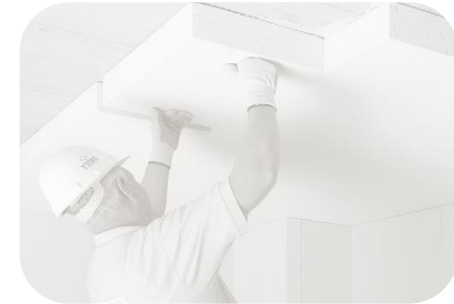
Plat dakisolatie binnenzijde
