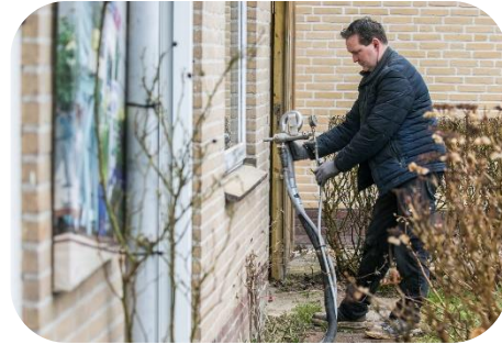
Spouwmuurisolatie
