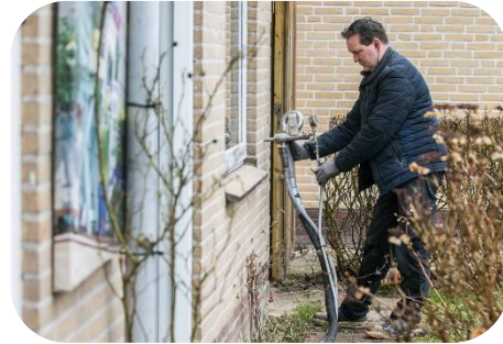
Spouwmuurisolatie
