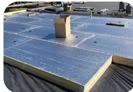
Plat dakisolatie buitenzijde
