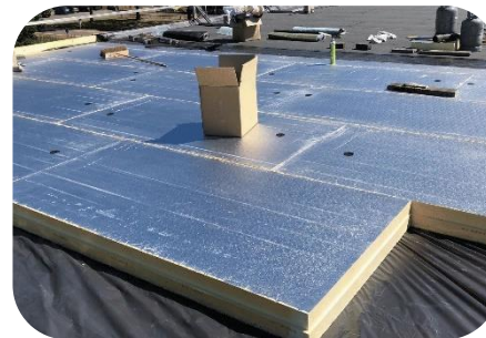
Plat dakisolatie buitenzijde
