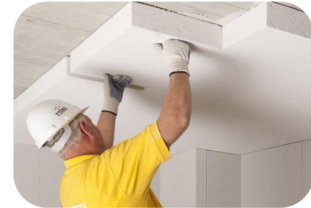
Plat dakisolatie binnenzijde
