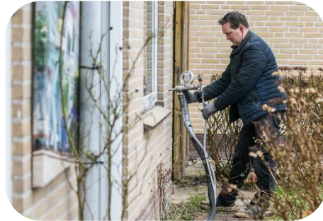
Spouwmuurisolatie
