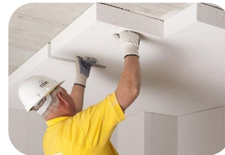
Plat dakisolatie binnenzijde
