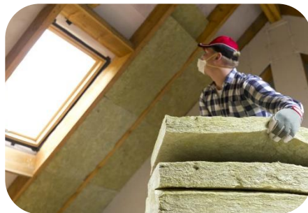
Schuin dakisolatie binnenzijde
