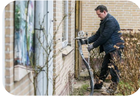
Spouwmuurisolatie
