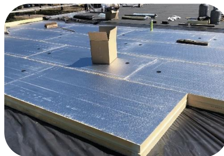
Plat dakisolatie buitenzijde
