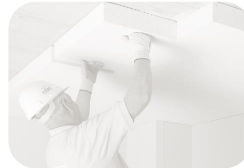
Plat dakisolatie binnenzijde
