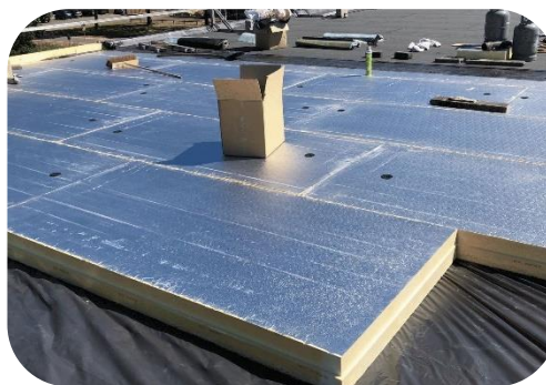
Plat dakisolatie buitenzijde
