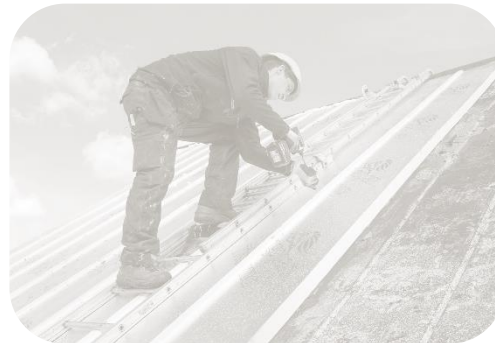
Schuin dakisolatie buitenzijde
