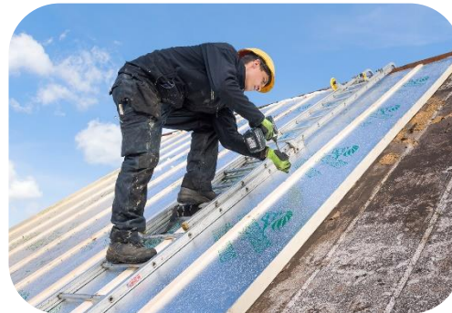
Schuin dakisolatie buitenzijde
