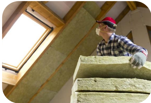
Schuin dakisolatie binnenzijde
