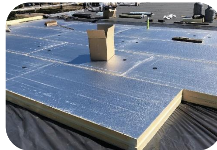
Plat dakisolatie buitenzijde
