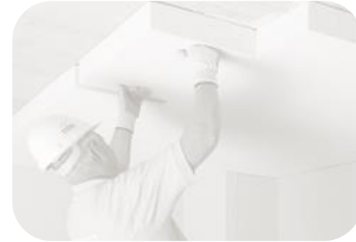
Plat dakisolatie binnenzijde
