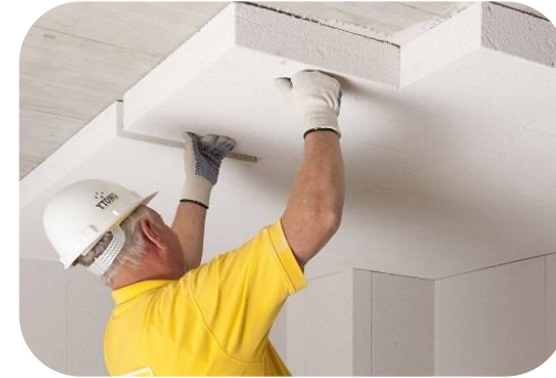
Plat dakisolatie binnenzijde
