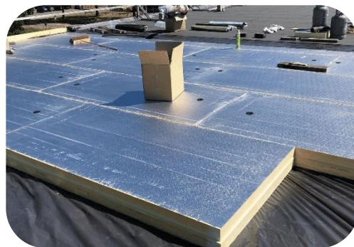
Plat dakisolatie buitenzijde
