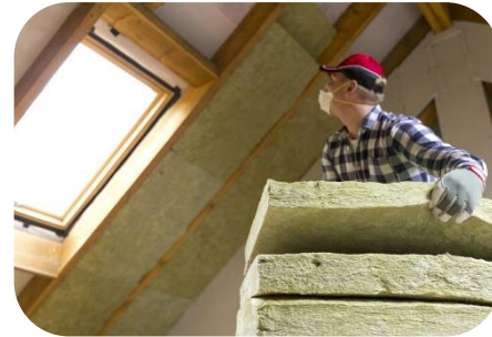
Schuin dakisolatie binnenzijde
