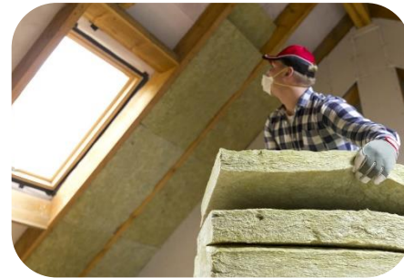
Schuin dakisolatie binnenzijde
