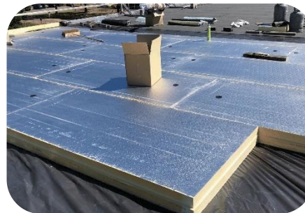
Plat dakisolatie buitenzijde
