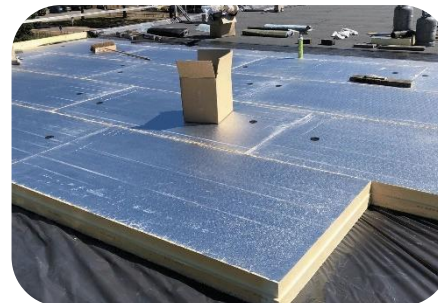
Plat dakisolatie buitenzijde
