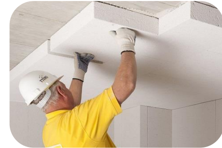
Plat dakisolatie binnenzijde
