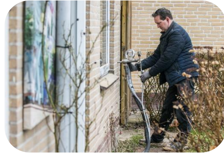
Spouwmuurisolatie
