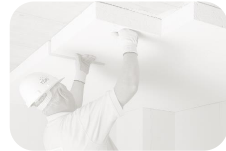
Plat dakisolatie binnenzijde
