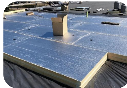
Plat dakisolatie buitenzijde
