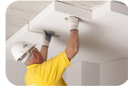
Plat dakisolatie binnenzijde
