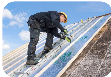
Schuin dakisolatie buitenzijde
