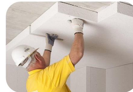
Plat dakisolatie binnenzijde
