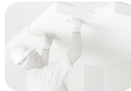
Plat dakisolatie binnenzijde
