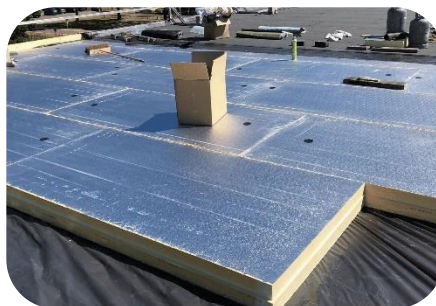
Plat dakisolatie buitenzijde
