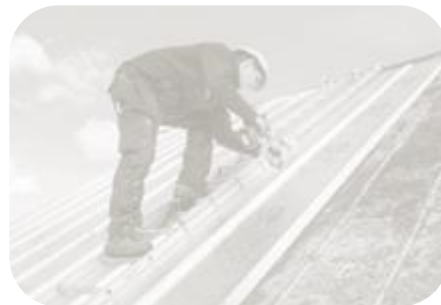
Schuin dakisolatie buitenzijde
