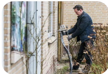
Spouwmuurisolatie
